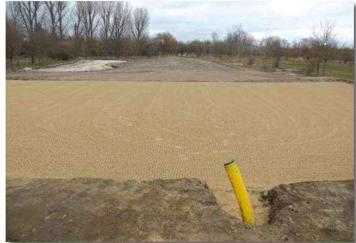
Platzbau neue Bahn 12 (Stand 06.03.2021)
