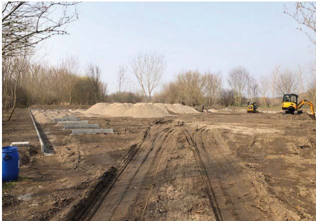
• Bau eines zusätzlichen Parkplatzes
