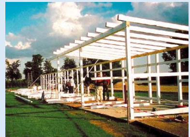
● und der Wetterschutz für die Driving-Range
