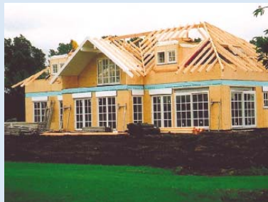
● Das Clubhaus entsteht
