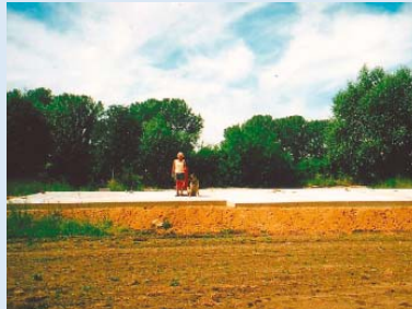
● Die Bodenplatte für das Clubhaus ist fertig
